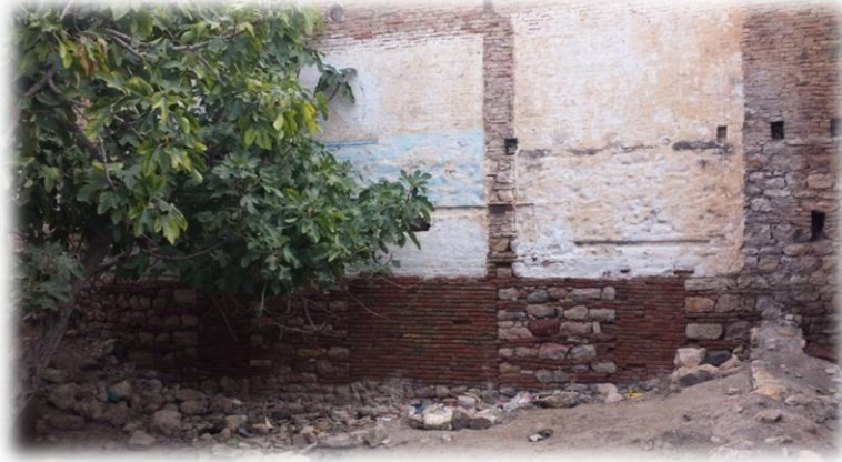
صورة (72): الواجهة الشمالية للمنزل
