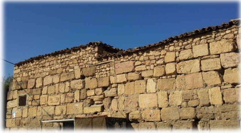
صورة (172): استغلال برج المراقبة كمنزل
