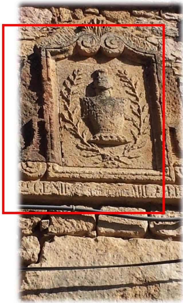
صورة (144) الزخارف المتواجدة في برج المراقبة
